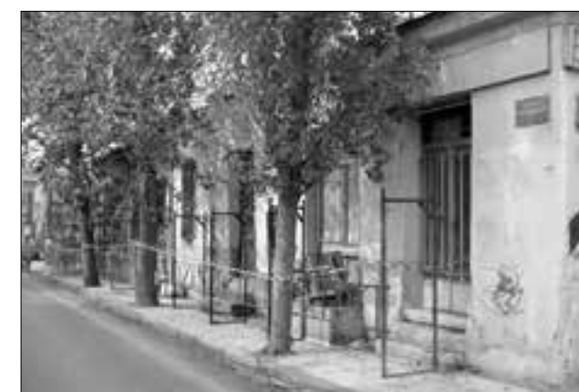
Εικ. 9. Γενική άποψη του περιβάλλοντος χώρου του Δημοσίου Σήματος πριν την κατεδάφιση των σύγχρονων κτηρίων
