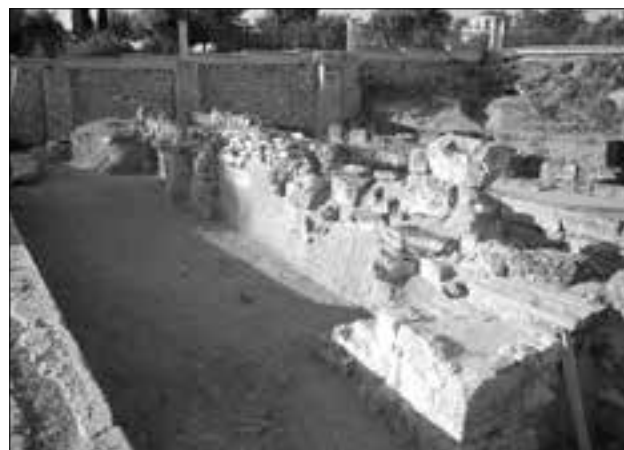
Εικ. 11. Κεραμεικός: Γενική άποψη του βόρειου αναλήμματος μετά τις εργασίες συντήρησης
