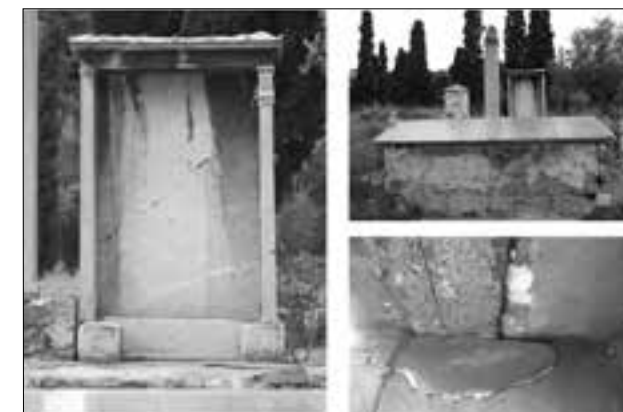
Εικ. 13. Κεραμεικός: Εργασίες συντήρησης στο μνημείο του Αγάθωνος
