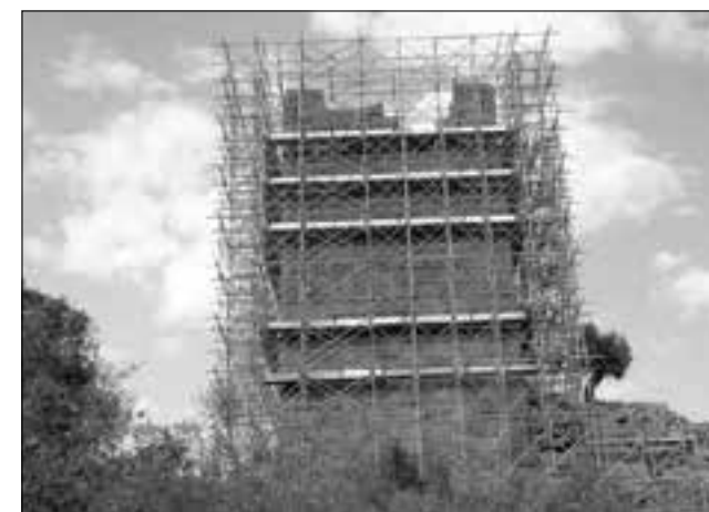
Ο υπό αναστήλωση πύργος του φρουρίου των Αιγιοσθένων
