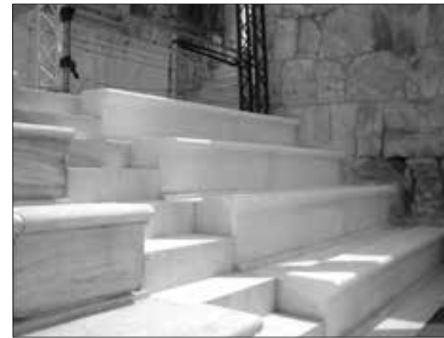
Εικ. 5. Ωδείο Ηρώδου Αττικού: Οι τρεις σειρές εδωλίων επάνω από την ανατολική πάροδο, μετά την ανακατασκευή τους
