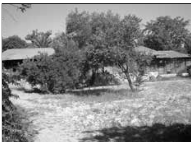
Εικ. 22. Ακαδημία Πλάτωνος: Υφιστάμενη κατάσταση του στεγαστρου προστασίας της «Ιεράς Οικίας»
