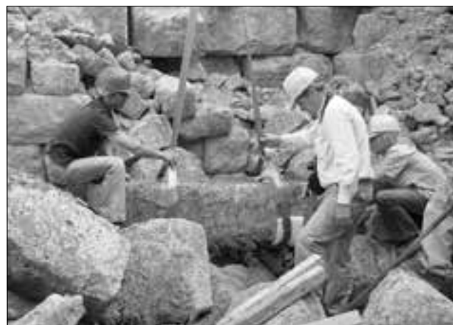
Εικ. 31. Αποσυναρμολόγηση περίπου 500 λιθοπλίνθων από τον ΝΑ πύργο του αρχαίου φρουρίου των Αιγιοσθένων
