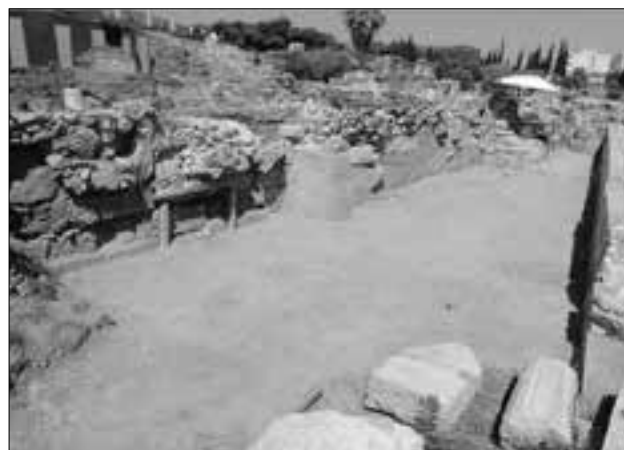
Εικ. 12. Κεραμεικός: Εργασίες ανάταξης και ενίσχυσης αναλημμάτων Ηριδανού
