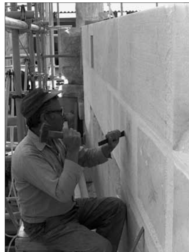
Τελική λάξευση από τον Α. Νικολούζο της επιφάνειας νέου μαρμάρου μέλους με κοπανάκι. Φωτ. Α. Παπανικολάου, 1981
