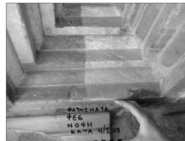
Καθαρισμός της φαινοματικής οροφής της Προστάσεως των Κορών με σύστημα laser, 2009
