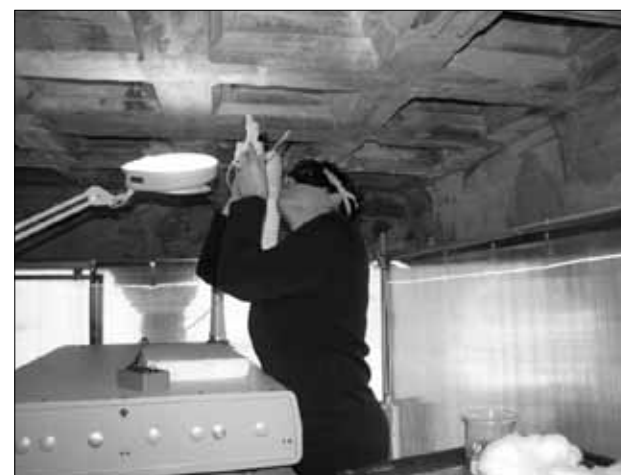
Καθαρισμός της φαινοματικής οροφής της Προστάσεως των Κορών με σύστημα laser, 2009
