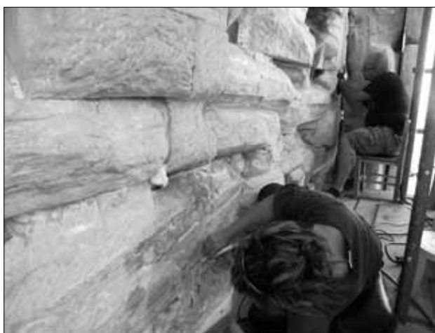
Δυτικός τοίχος, εσωτερική όψη: εργασίες πλήρωσης των ρωγμών με ενέματα, 2011
