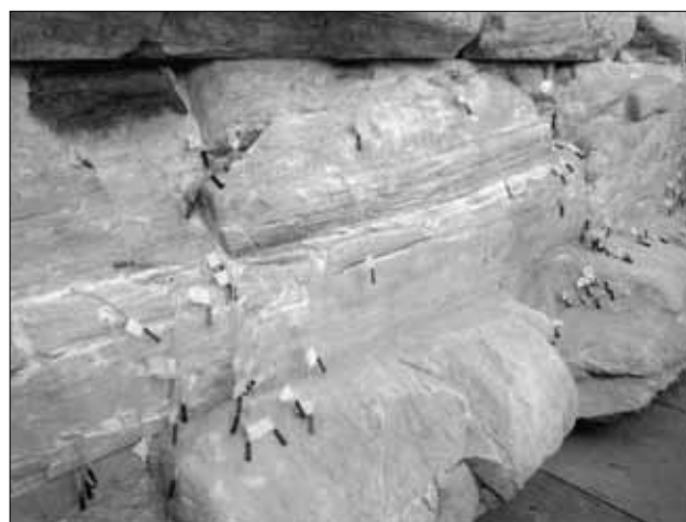
Δυτικός τοίχος, εσωτερική όψη: εργασίες πλήρωσης των ρωγμών με ενέματα, 2011
