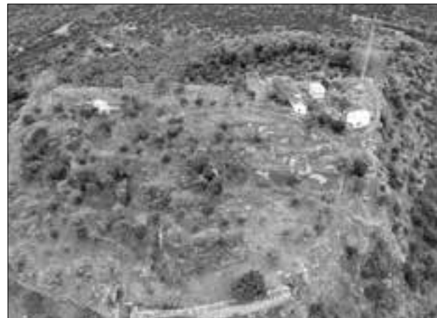
Εικ. 33. Αεροφωτογραφία του αρχαίου φρουρίου των Αιγισθέων κατά την διάρκεια των εργασιών
