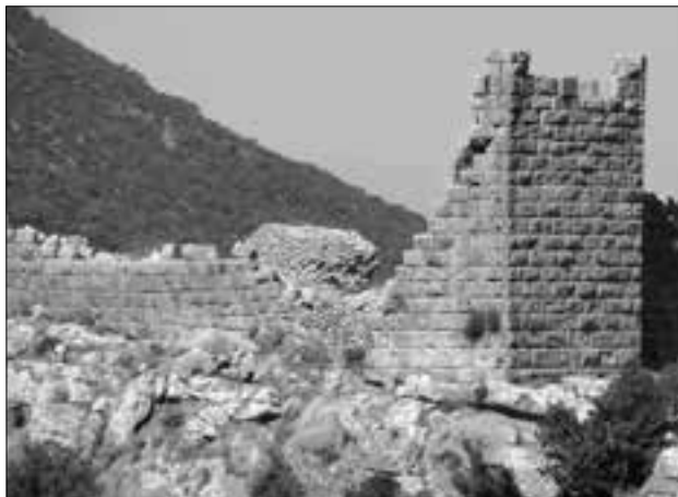
Εικ. 32. Ο ΒΑ πύργος του αρχαίου φρουρίου των Αιγισθέων πριν την έναρξη των εργασιών
