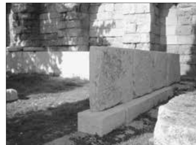
Εικ. 9. Στοά Ευμένους: Η βορειοανατολική γωνία μετά την αποκατάσταση
