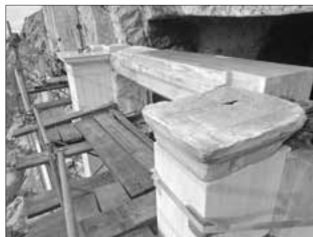
Εικ. 3. Χορηγικό Μνημείο του Θρασύλλου: Λεπτομέρεια από την αποκατάσταση του δυτικού ανοίγματος του στο ύψος των επικράνων
