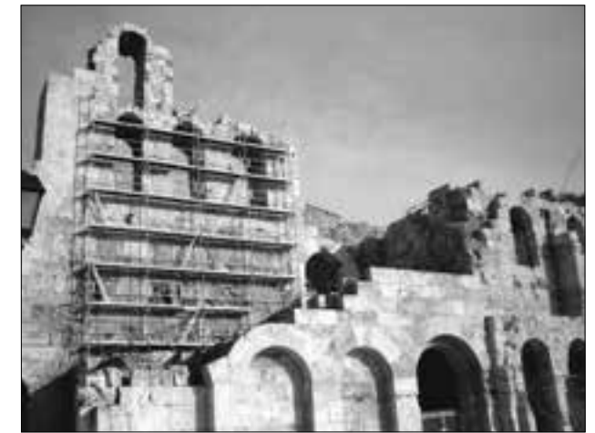
Εικ. 6. Ωδείο Ηρώδου Αττικού: Ο δυτικός μετωπικός τοίχος του κοίλου. Προετοιμασία για την εκτέλεση εργασιών αποκατάστασης
