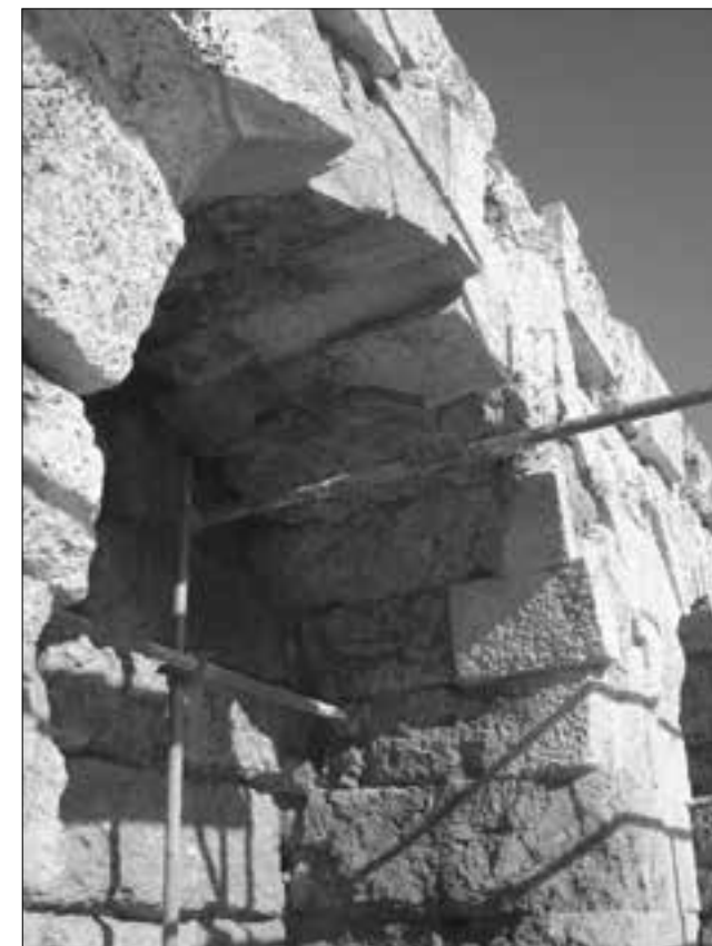
Εικ. 8. Στοά Ευμένους: Λεπτομέρεια από τις εργασίες αποκατάστασης ενός εκ των μεσαίων τόξων
