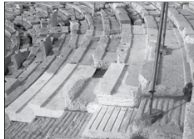
Εικ. 1. Θέατρο Διονύσου: Τμήμα της κερκίδας VIII, όπου εκτελούνται εργασίες αποκατάστασης
