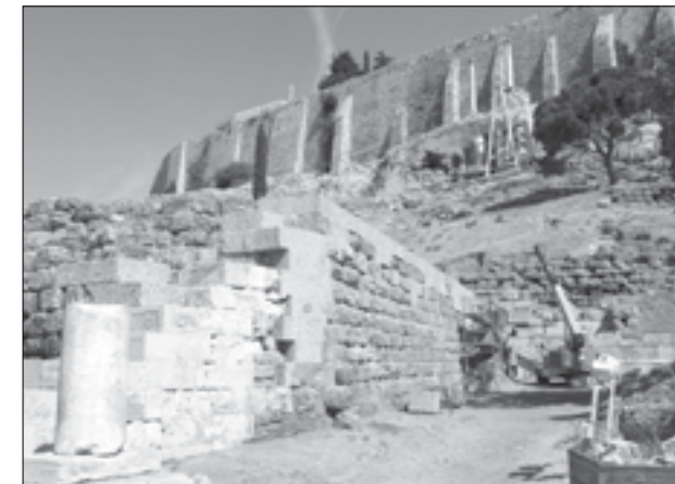
Εικ. 2. Θέατρο Διονύσου: Το ανατολικό πλευρικό ανάλημμα του θεάτρου κατά την εκτέλεση των εργασιών αποκατάστασης
