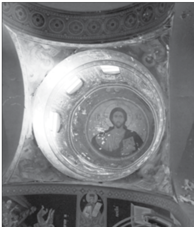
Εικ. 1. Ναός Μεταμόρφωσης Κοττάκη. Άποψη του τρούλου, εσωτερικά
