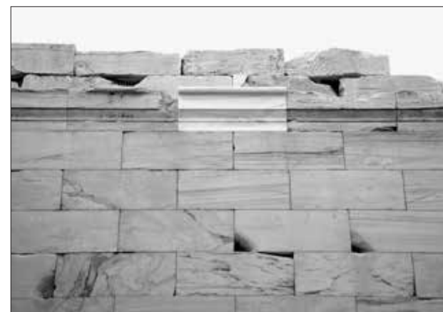
Εικ. 10. Ο νότιος τοίχος του κεντρικού κτηρίου των Προπυλαίων, με τον θράνο από νέο μάρμαρο. Άποψη από το εσωτερικό του μνημείου
