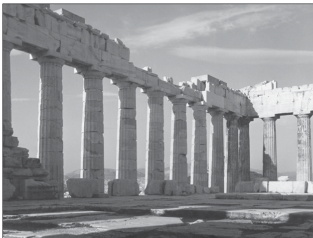
Η βόρεια κιονοστοιχία του Παρθενόνος από ΝΑ. Φωτ. Α. Χαρισιάδη, δεκαετία 1950. Στο πίσω μέρος φέρει ιδιόχειρη σημείωση του Γ.Μ.: «Η βόρεια κιονοστοιχία του Παρθενώνα που αναστηλώθηκε προπολεμικά από τον Μπαλάνο. Πρέπει ολόκληρη να καταδαφιστεί και να ξαναγίνει, αφού αντικατασταθούν οι σιδερένιοι σύνδεσμοι». Αρχείο ΕΣΜΑ
