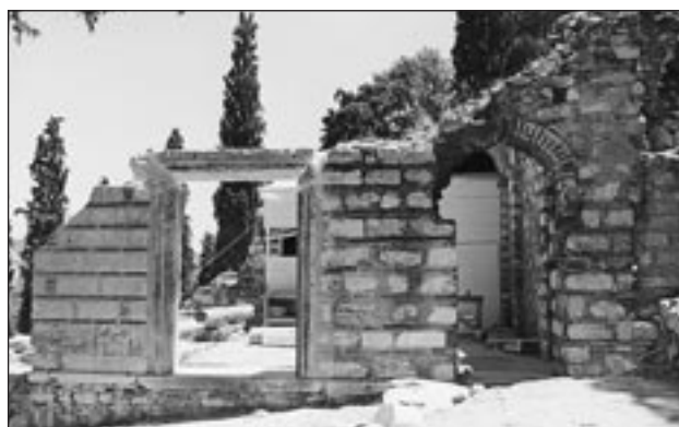
Εικ. 5. Βόρεια κλιτύς Ακροπόλεως. Αποκατάσταση περιθρομάτος Αγ. Νικολάου
