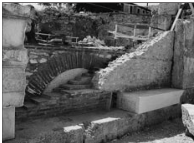
Η συμπλήρωση της εσωτερικής παρειάς του τοίχου της νότιας πτέρυγας της πρόσοψης της Βιβλιοθήκης Αδριανού, 2004.
