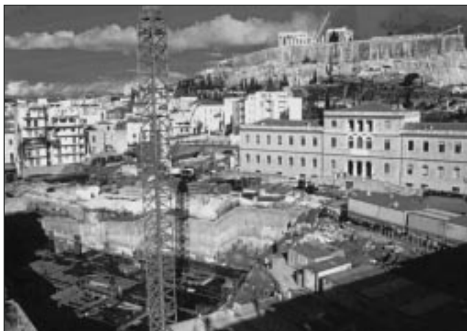
Φωτ. 17. Το Νέο Μουσείο Ακρόπολεως υπό κατασκευή.
