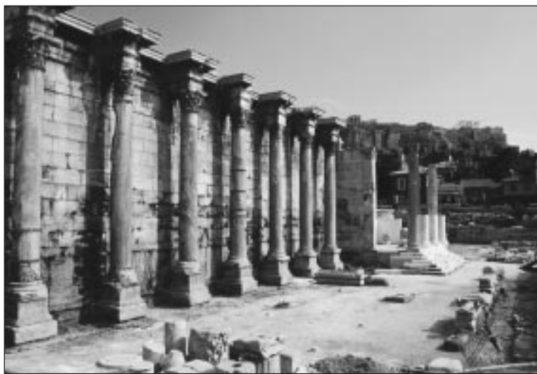
Φωτ. 11. Αποκατάσταση προπύλου και εξωτερικής αυλής Βιβλιοθήκης Αδριανού.
