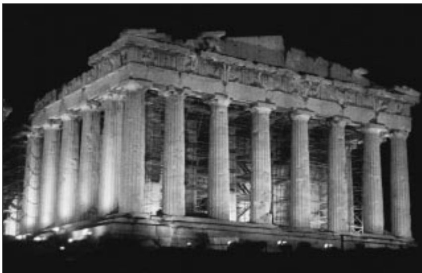
Φωτ. 1. Ο φωτοαγωγημένος Παρθενών από δυτικά.
