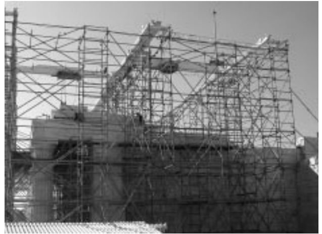
Εικ. 11: Ο βόρειος τοίχος του κεντρικού κτηρίου των Προπυλαίων, μετά την πρόσφατη μερική αναστήλωσή του (2003-2004) (Φωτ. Τ. Τανούλας, 2005)
