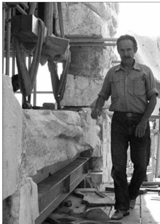
Ο Ν. Σκαρής στη διάρκεια του έργου της αποκατάστασης του Ερεχθείου
