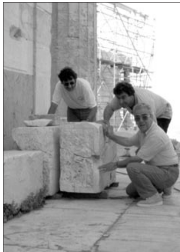
Ο Κ. Θεοτικός στη διάρκεια του έργου της αποκατάστασης των Προπυλαίων
