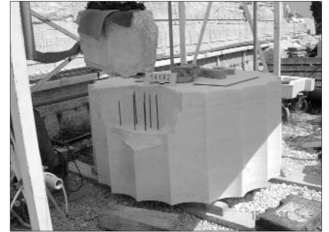
Εικ. 1. Εφαρμογή ράβδων τιτανίου για τη συγκόλληση τμημάτων αρχιτεκτονικών μελών
