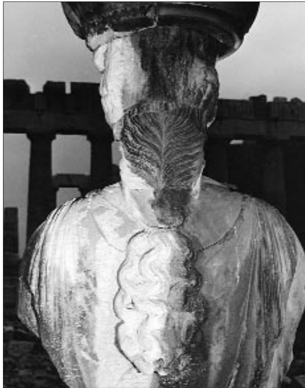
Εικ. 2. Διατήρηση λεπτομερειών στο πίσω μέρος Καρυατίδας, το οποίο προστατεύεται από το νερό της βροχής. Οι λεπτομέρειες διατηρούνται πάνω στα στρώματα του γύψου
