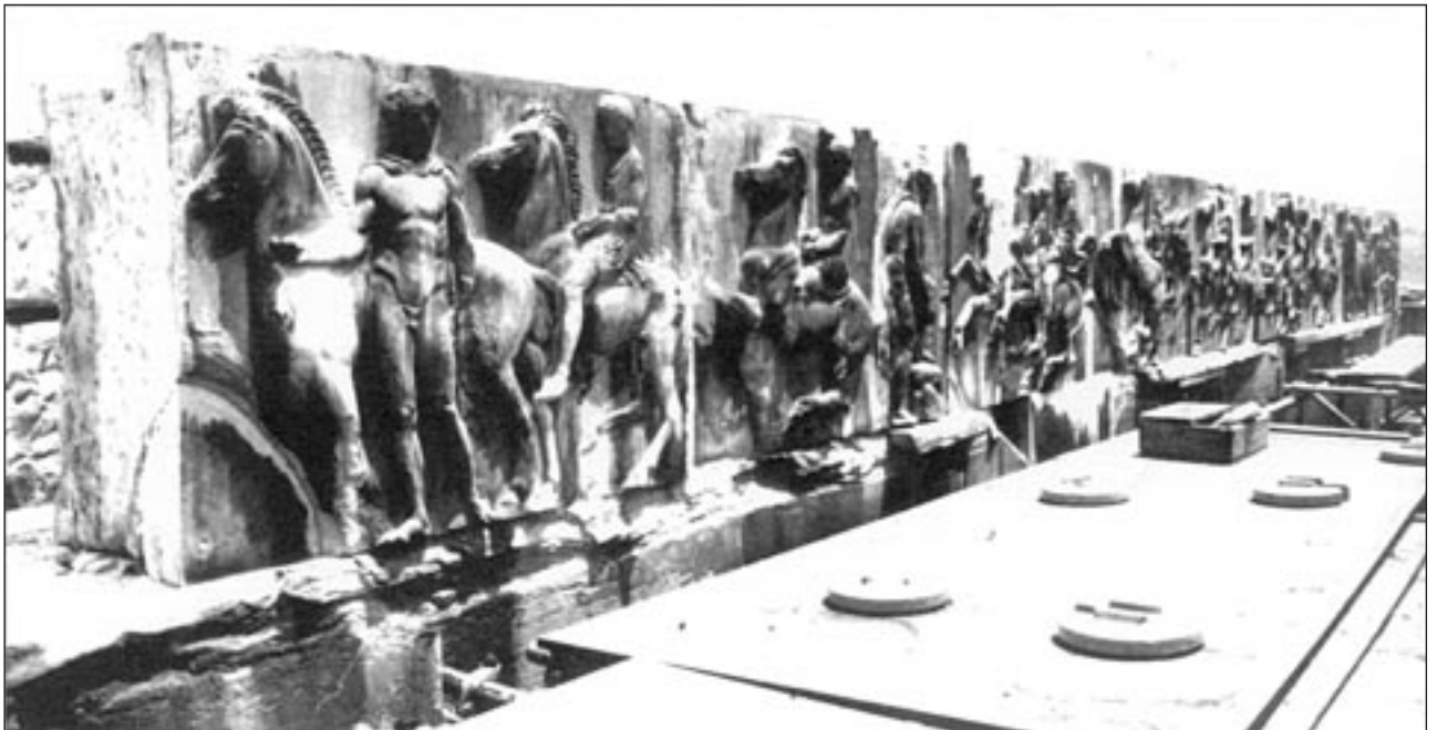
Η δυτική ζωφόρος του Παρθενónος μετά την απομάκρυνση των δοκών του δυτικού πτερού και των θράνων (1993).
