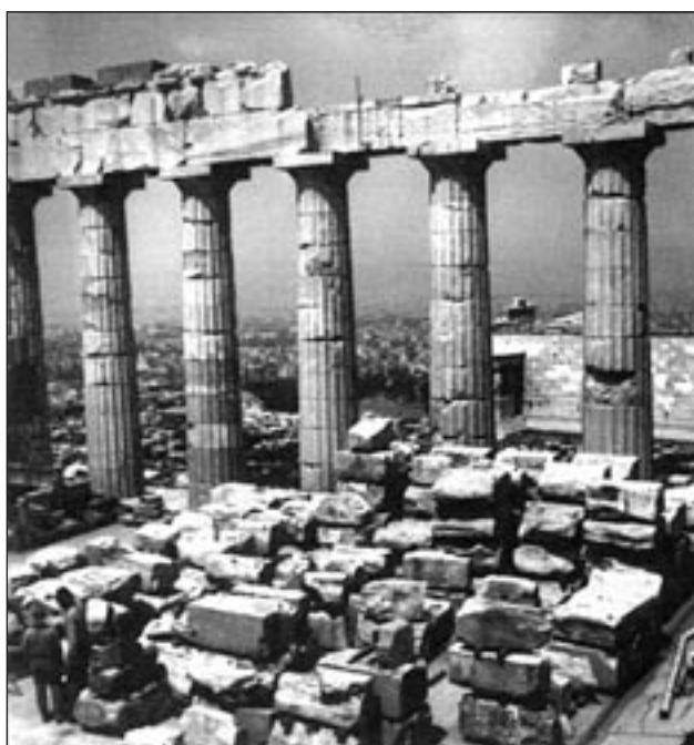
Το εσωτερικό του σηκού του Παρθενώνος μετά την καθαίρεση μεγάλου μέρους των τοίχων του σηκού (έργα 1992).
