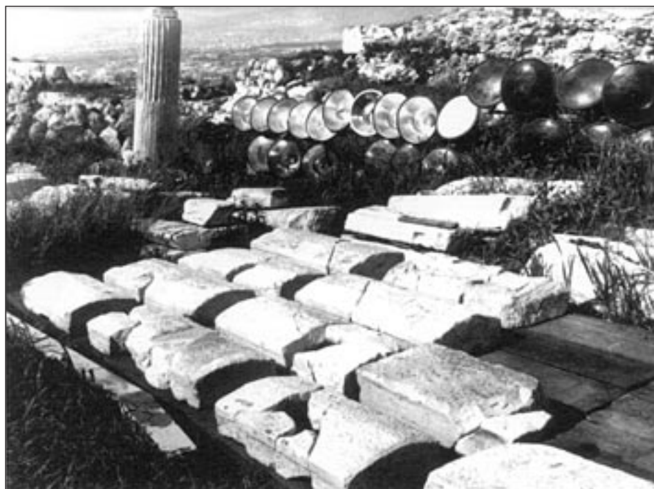
Προπύλαια. Φαινοματικές πλάκες της οροφής οι οποίες απαρτίσθηκαν από θραύσματα - Έργα 1994.
