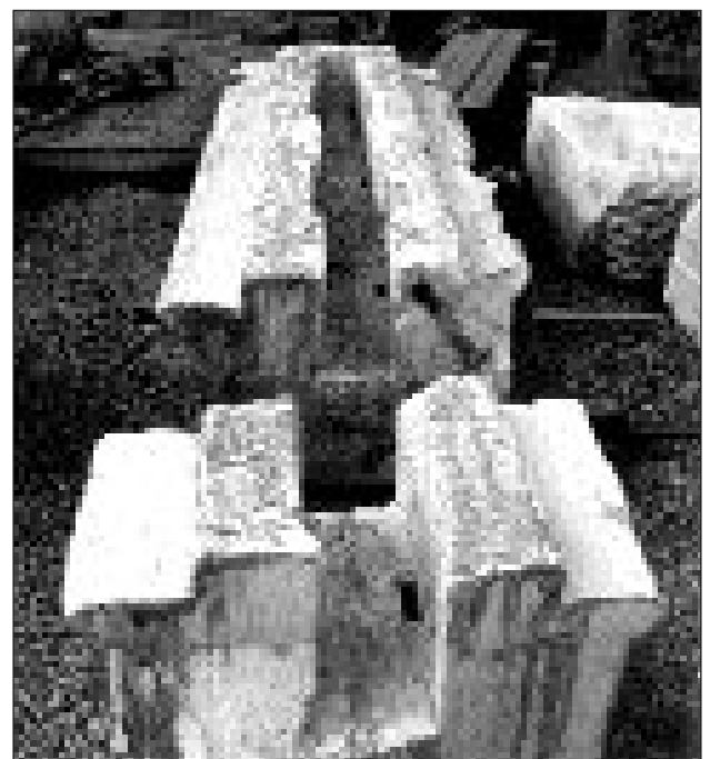
Προτύπια. Μια από τις δοκούς της οροφής μετά την απομάκρυνση των οξειδωμένων ένθετων σιδηρών στοιχείων της αναστηλώσεως Μπαλάνου.
