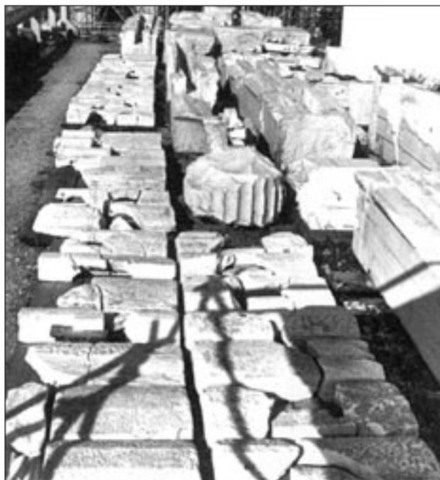
Προπύλαια. Φατνωματικές πλάκες της οροφής οι οποίες απαρτίσθησαν από θραύσματα – Έργα 1995.
