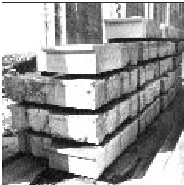
Οι θράνοι οι υπερκείμενοι της δυτικής ζωφόρου του Παρθενώνος μετά την συμπλήρωση και την συντήρησή τους.
