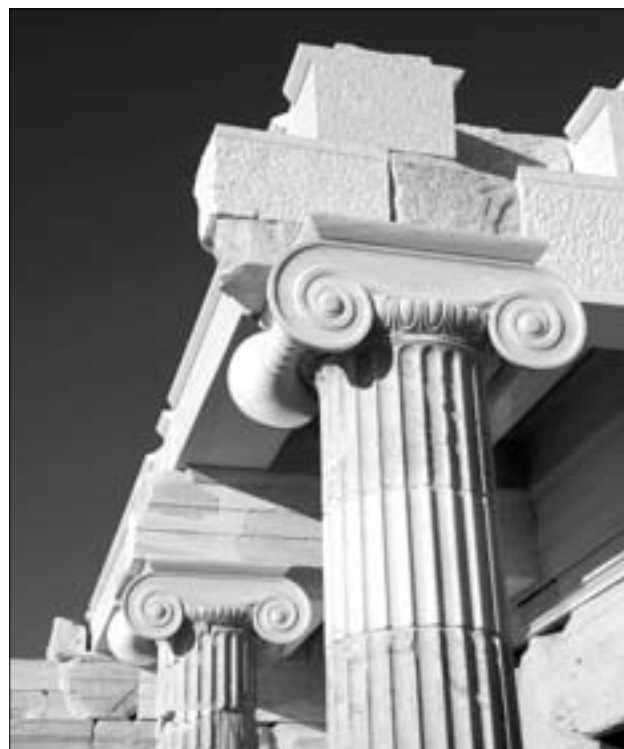
Τα νέα ιωνικά κιονόκρανα που υποστηρίζουν την αποκατεστημένη οροφή του κεντρικού κτηρίου των Προπυλαίων (2010)
