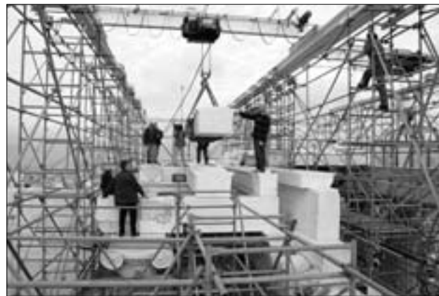
Στιγμιότυπο από την ανατοποθέτηση των αποκατεστημένων δοκών της οροφής του κεντρικού κτηρίου των Προπυλαίων (2009)
