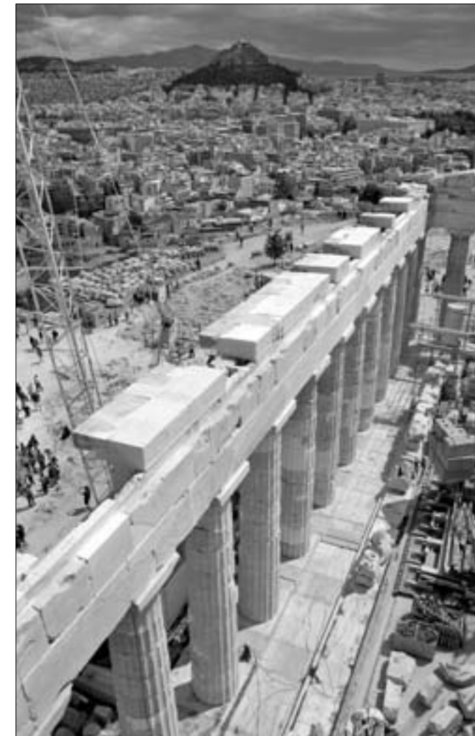
Η βόρεια κιονοστοιχία του Παρθενώνα μετά την πρόσφατη αναστήλωσή της. Άποψη από ΝΔ, στη στάθμη του θριγκού. Φωτ. Σ. Μανρομμάτης, 2010
