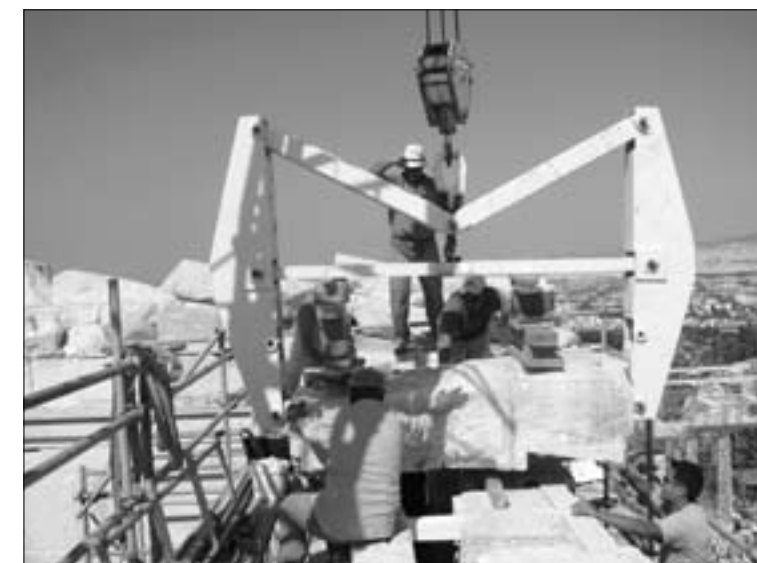
Ανατοποθέτηση λίθου γέισου στη βόρεια κιονοστοιχία του Παρθενώνα με ειδικά σχεδιασμένη αρπάγη. Φωτ. Β. Ελευθερίου, 2009
