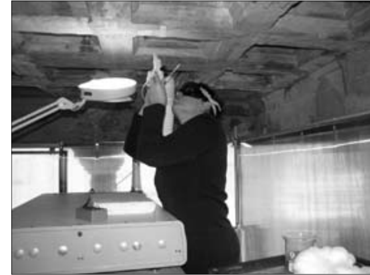
Εργασίες καθαρισμού της οροφής της νότιας πρόστασης του Ερεχθείου με χρήση τεχνολογίας λέιζερ. Φωτ. Γ. Φραντζή, 2009
