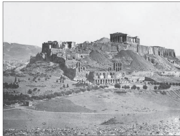
Εικ. 11. Άποψη της Ακρόπολης από ΝΔ. Διακρίνεται, ερειπωμένος, ο Σερπεντζές στη νότια κλιτύ. Φωτ. Δ. Κωνσταντίνου, ca. 1875, Φωτ. Αρχείο ΕΙΜ
