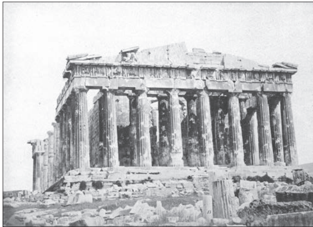
Εικ. 28. Άποψη του Παρθενόνα από Δ. Στη δυτική όψη και στους κίονες του οποίων διακρίνονται τα ίχνη από τους κανονισμούς των πολιορκιών της Ακρόπολης. Φωτ. Π. Μωραΐτης, 1865, Φωτ. Αρχείο ΕΙΜ
