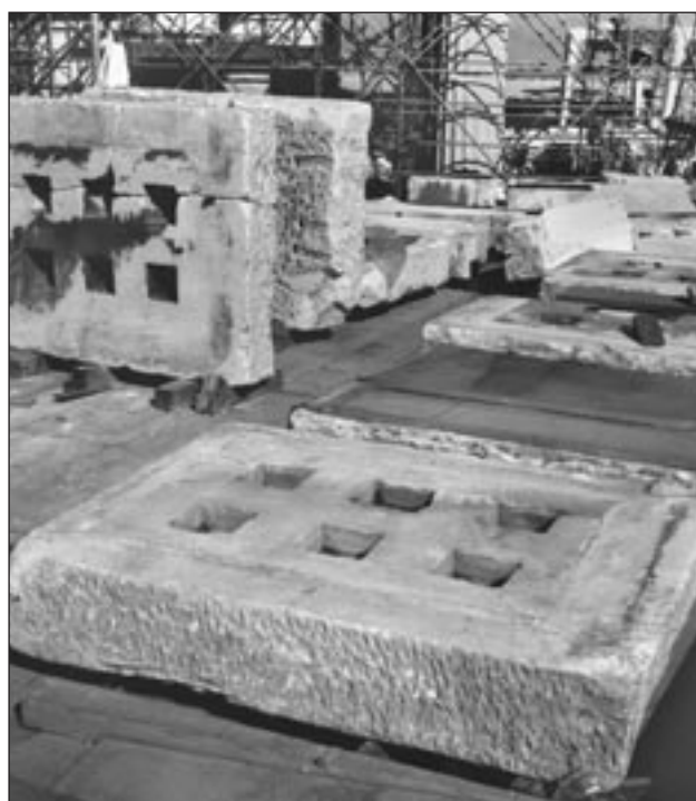
Ναός της Αθηνάς Νίκης. Οι φαντασματικές πλάκες της οροφής μετά την αποσυναρμολόγησή τους.
