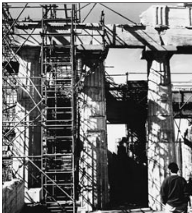
Προπύλαια. Το νότιο άκρο της ανατολικής στοάς με τα κριώματα αποκαταστάσεως της νοτιοανατολικής γωνίας.
