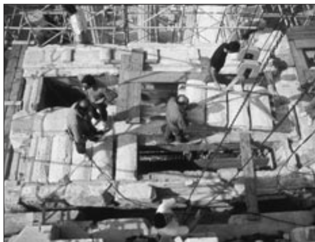
Αποξήλωση φαντομάτων της αναστηλωμένης οροφής της ανατολικής στοάς του κεντρικού κτηρίου των Προπυλαίων. Φωτ. Τ. Τανούλας, 1992
