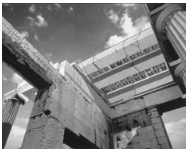
Η οροφή της ανατολικής στοάς του κεντρικού κτηρίου των Προπυλαίων, όπως είχε αναστηλωθεί από τον Ν. Μπαλάνο.
