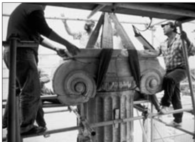
Η αποξήλωση του συναρμολογημένου από τον Μπαλιάνο κιονογράνου του ιωνικού γίονα που υποβάσταζε την αναστηλωμένη οροφή της δυτικής αίθουσας του κεντρικού κτηρίου των Προπυλαίων. Φωτ. Μ. Ιωαννίδου, 1993
