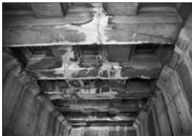
Η αναστηλωμένη από τον Ν. Μπαλάνο οροφή της ανατολικής στοάς των Προπυλαίων. Αποψη από Ν. Φωτ. Τ. Τανούλας, 1990
