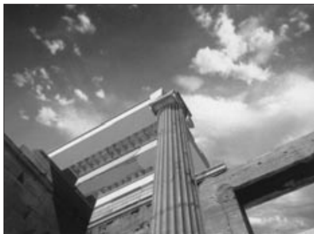
Η οροφή της δυτικής αίθουσας του κεντρικού κτηρίου των Προπυλαίων, όπως είχε αναστηλωθεί από τον Ν. Μπαλάνο. Φωτορεαλιστική απεικόνιση
