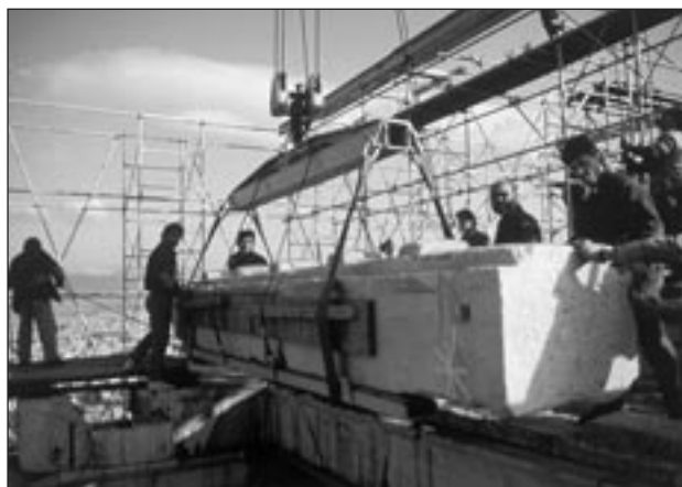
Αποξήλωση δοκών της αναστηλωμένης οροφής της δυτικής αίθουσας του κεντρικού κτηρίου των Προπυλαίων. Φωτ. Μ. Ιωαννίδου, 1992
