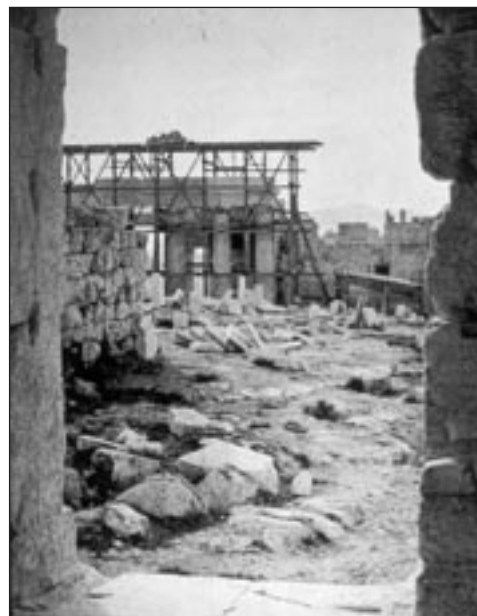
Αναστηλωτικές εργασίες στα Προπύλαια από τον Ν. Μπαλάνο (1909-1917). Φωτ. Fr. Boissonas
