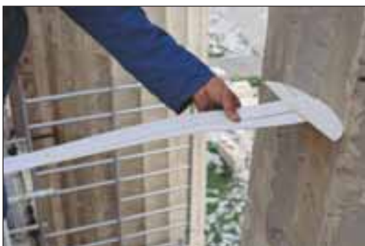
Εικ. 24. Η διατομή της ράβδωσης σε κάθε θέση είναι δυνατό να γράφεται με ένα διαβήτη με μήκος σκελών ίσο με το διπλάσιο της χορδής και με δύο τύπους προσαρμωσμένους στα άκρα του.
