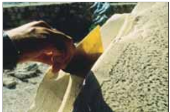
Εικ. 23. Η ίδια έλλειψη χρησιμοποιήθηκε και για τη διαμόρφωση των αυλάκων των ραβδώσεων και στους σπόνδυλους του Προπαρθενώνος. Συνεπώς η έλλειψη είναι γνωστή και έχει χαρακτηί με ακρίβεια στον Προπαρθενώνα, δύο αιώνες πριν από το περίφημο “Περί Κωνικών” σύγγραμμα του μεγάλου μαθηματικού της αρχαιότητας Απολλωνίου.
