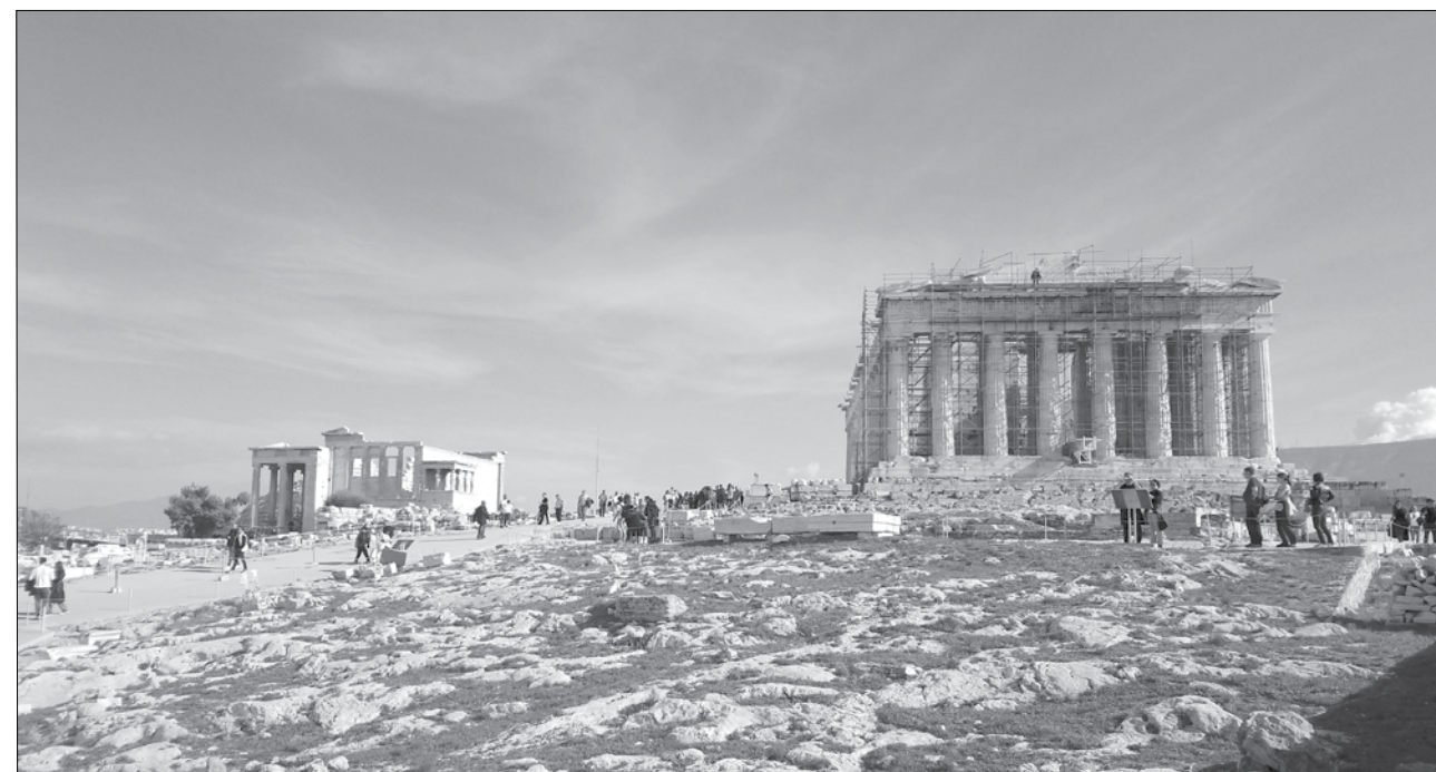
Στο τέλος του 2023 αποκαταστάθηκε το Β. τμήμα του Δ. αετώματος του Παρθενώνα, αποδίδοντάς του πάλι το γνωστό περίγραμμα. Οι εργασίες συνεχίζονται στο νότιο τμήμα, όπου προβλέπεται πλήρης συμπλήρωση του τμημάτων με χρήση αρχαίων θραυσμάτων και ενός λίθου εξ ολοκλήρου από νέο μάρμαρο. Φωτ. Β. Ελευθερίου, 2024
