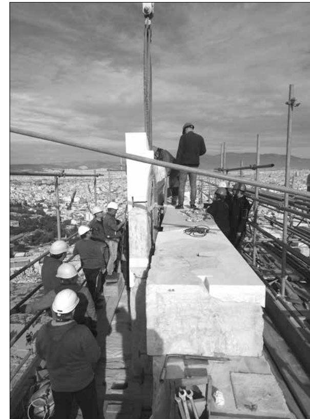
Η τοποθέτηση του κεντρικού ορθοστάτη του τυμπάνου του δυτικού αετώματος του Παρθενώνα. Φωτ. Β. Ελευθερίου, 2023
