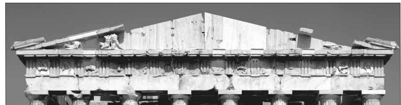
Εικ. 9. Πρόταση πλήρους συμπλήρωσης τυμπάνου δυτικού αετώματος. Μελέτη Β. Ελευθερίου-Β. Μανιδάκη, 2007
