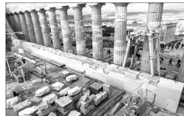
Εικ. 5. Ο βόρειος τοίχος αναστηλωμένος έως και τον 2ο δόμο. Φωτ. Τ. Σουβλάκης, 2024
