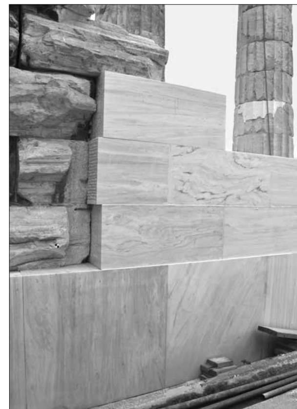
Εικ. 14. Συμπλήρωση της βυζαντινής θύρας στη νότια πλευρά του βόρειου τοίχου. Φωτ. Ρ. Χριστοδουλοπούλου, 2023
