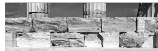
Εικ. 6. Τμήμα των αναστηλωμένων δόμων στον βόρειο τοίχο με το σύστημα της στατικά εξασφαλισμένης απόθεσης. Φωτ. Τ. Σουβλάκης, 2024
