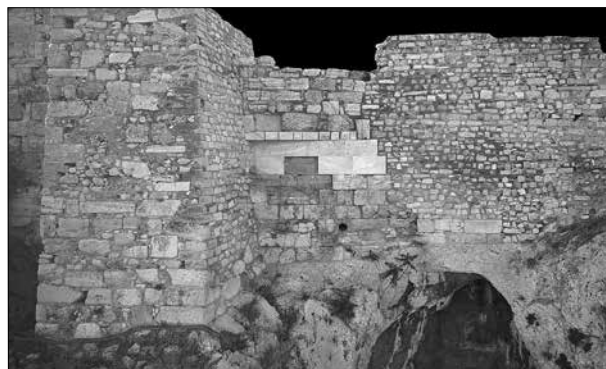
Εικ. 7. Η περιοχή Β17 του βόρειου τείχους μετά την αποκατάσταση
