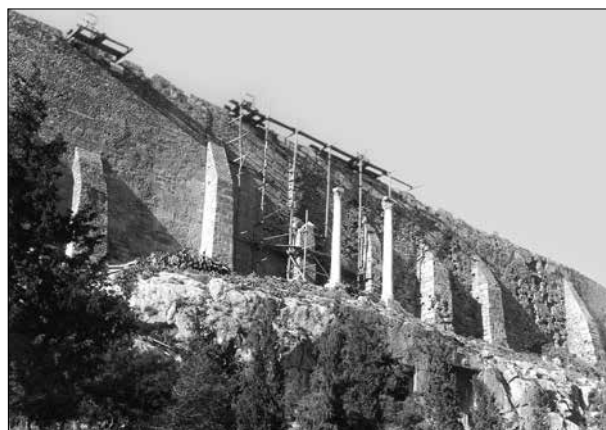
Εικ. 2. Εργασίες στερέωσης στο νότιο τείχος από τον Α. Ορλάνδο (1950)
